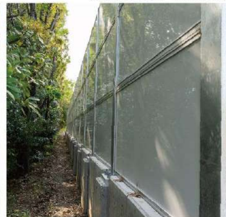
敷地境界（民家側）
