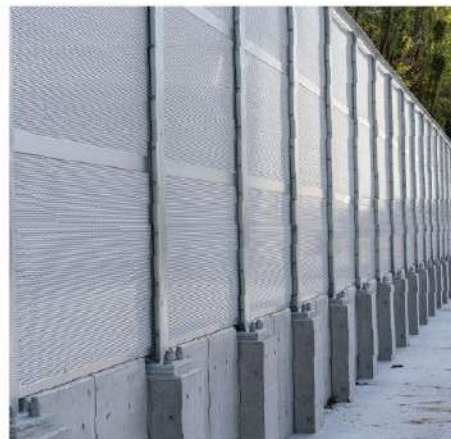
敷地境界（倉庫側：吸音面）
