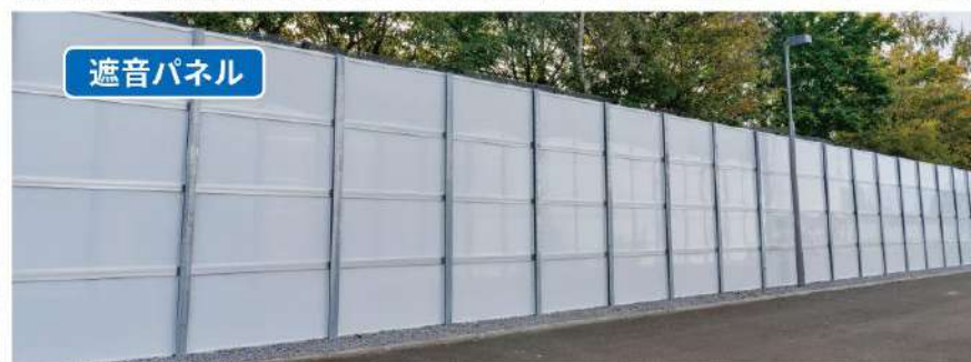
写真上：吸音パネル（騒音源建物側）、写真下：遮音パネル（敷地境界側）
