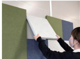
パネルは軽量でマグネットで簡単に設置ができ、気軽に着脱も可能。
